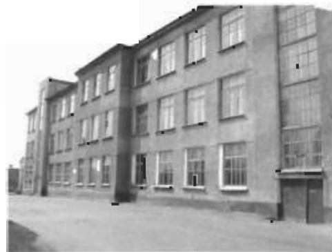
▲ Фрагмент главного фасада
