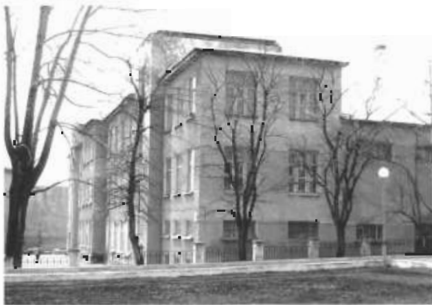
▲ Фрагмент бокового фасада
