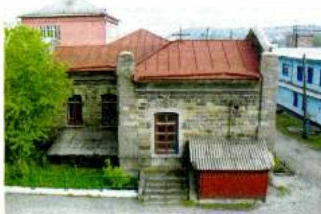
крыльца и перемычки окон полуподвального этажа западного фасада выполнены из монолитного бетона.
