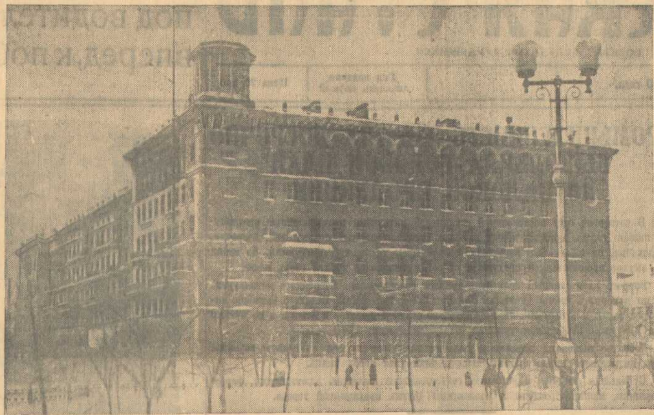
По проспекту имени Кирова строятся два новых 140-квартирных дома для металлургов Кузнецкого комбината. Это будут лучшие жилые здания города. Оба дома вступят в эксплуатацию в 1950 году. На снимке: фасад одного из строящихся домов. Фото Н. Никитина.
