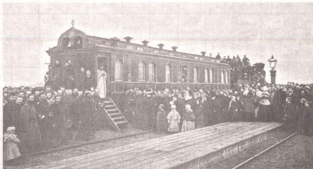
■ Раньше по строящейся железнодорожной магистрали курсировал специальный вагон, стилизованный под церковь. Фото из архива Тайгинского исторического музея.
