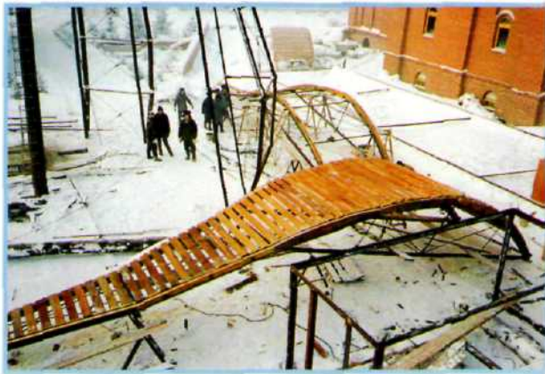
Монтаж сегментов главного купола.
