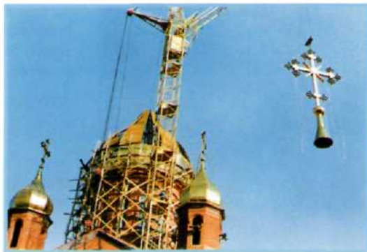
Установка главного купольного креста.
