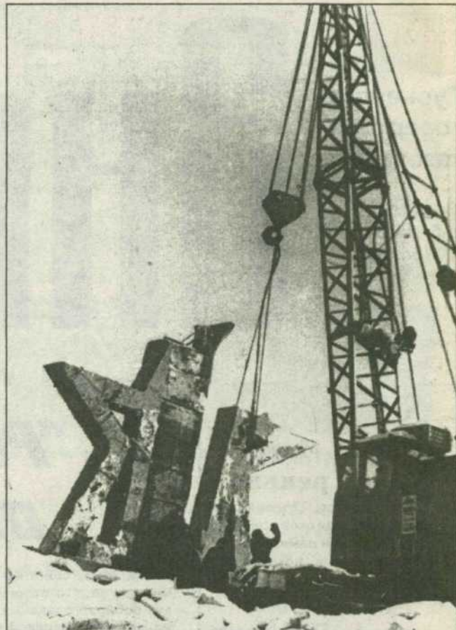
Идет сооружение памятника.
