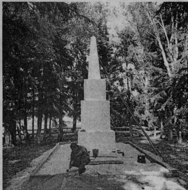
■ Заключительные работы по обновлению памятника.
